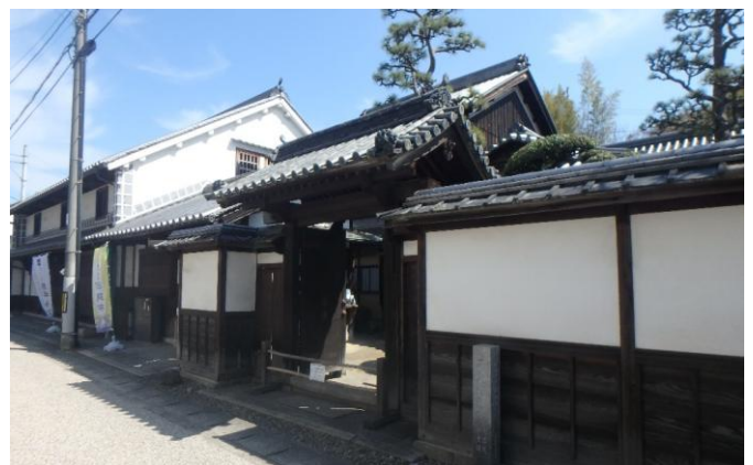
「みなとオアシス玉島」の代表施設である 旧柚木家住宅(西爽亭)
