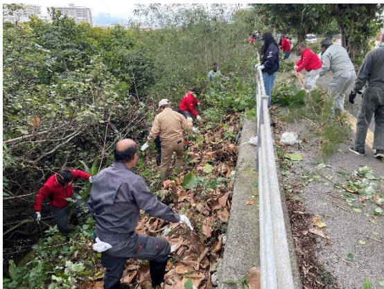
湿地周辺の草木伐採の様子
