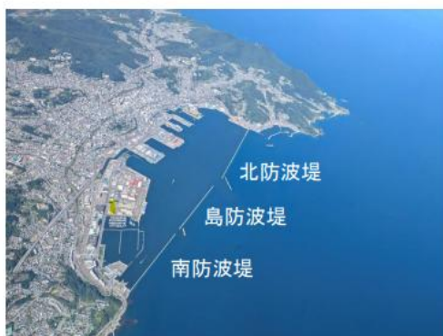
小樽港防波堤施設
