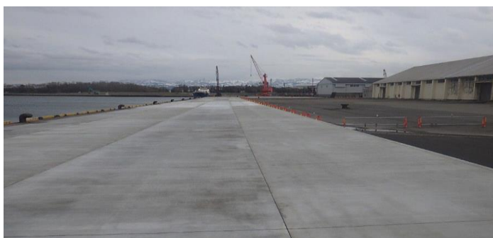
本復旧工事完了後の様子
