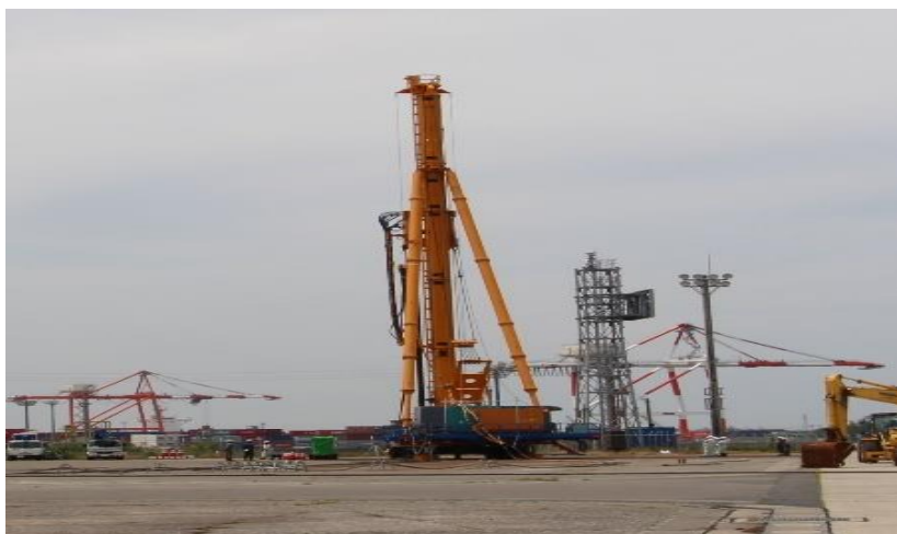
工事開始により起動した地盤改良機
