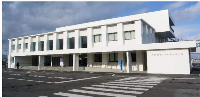
新ターミナルビルの外観
