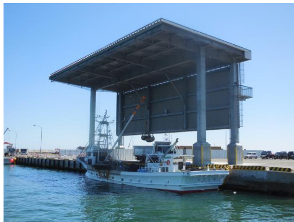
本港地区屋根付き岸壁
