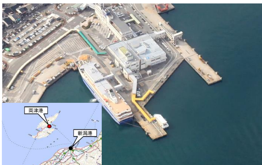
両津港南埠頭とフェリーターミナル
