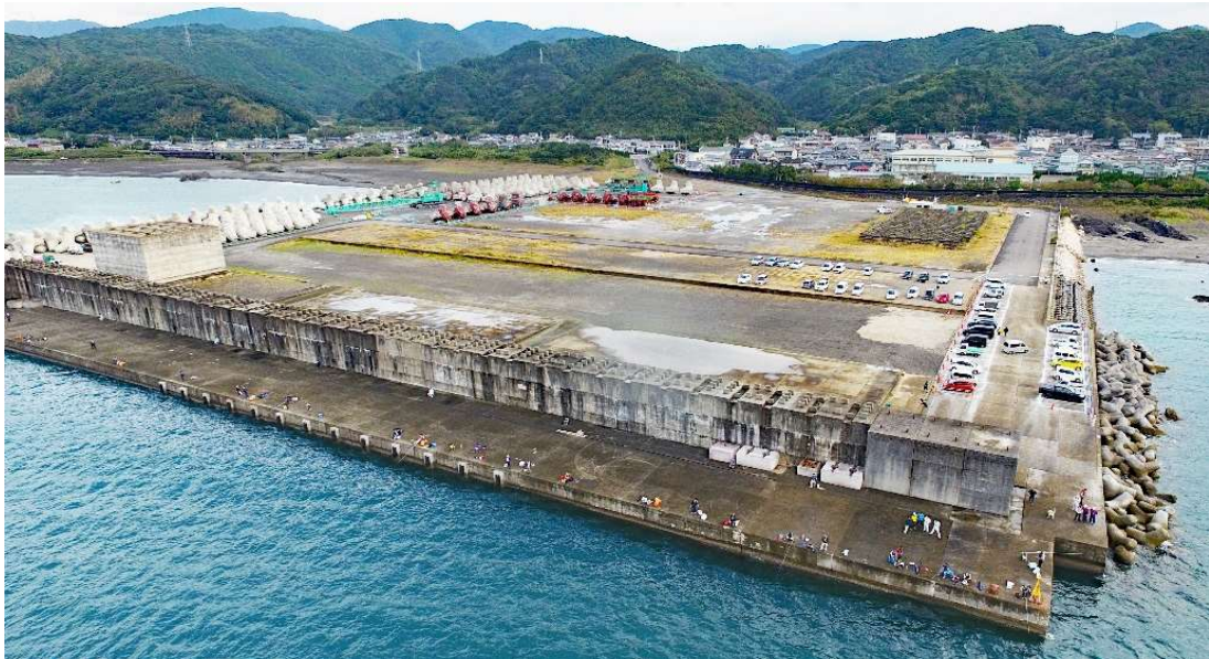
室津港作業ヤード全景
