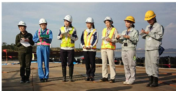
安全パトロールの様子
