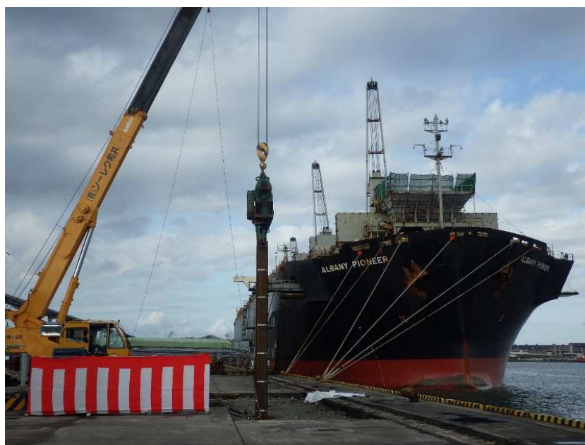
1本目の矢板打設
