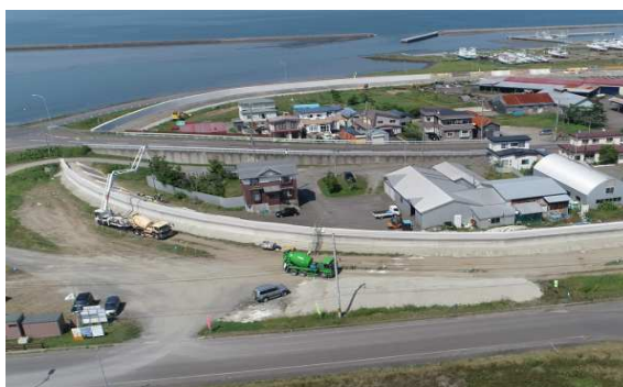
改修工事中の防潮堤
