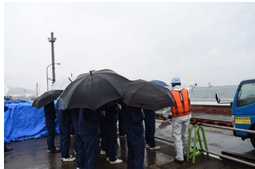
岸壁の現場見学
