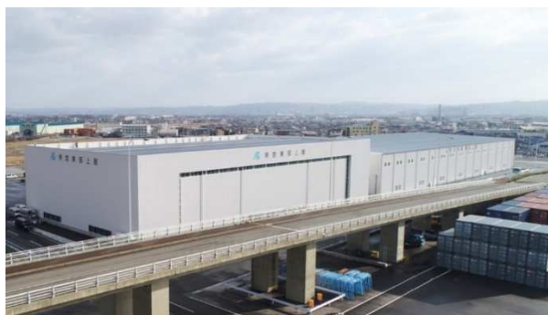
完成した金沢港県営東部上屋
