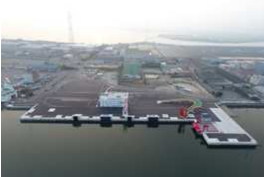
完成した耐震強化岸壁
