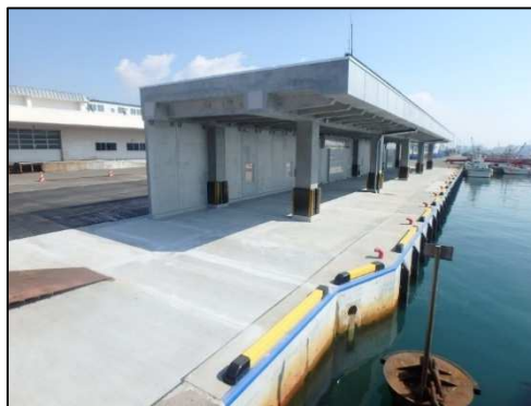
屋根付岸壁全景
