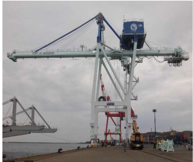
ガントリークレーン全景
