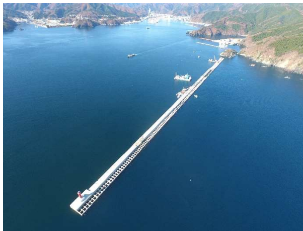
▲最終函据付が完了した北堤 (H29. 12. 1撮影)
