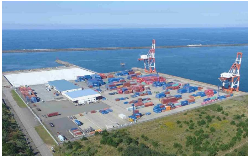
【拡張工事が完了した高砂ふ頭コンテナヤード】
