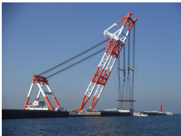
起重機船「洋翔」に釣り上げられるケーソン
