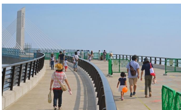
「未完成の橋を歩けるのは貴重な機会」と参加者からも好評
