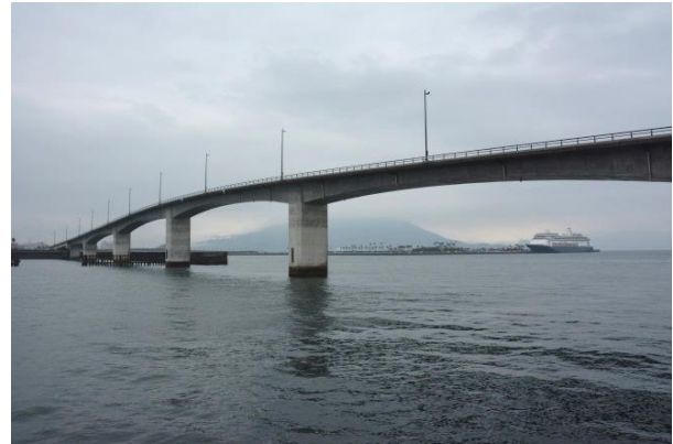
黎明みなと大橋
