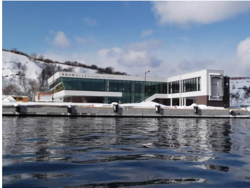
鴛泊港フェリーターミナル
