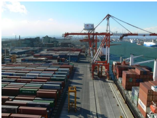
高砂コンテナターミナル（H26. 2. 5撮影）
