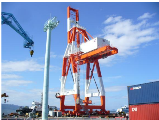
ガントリークレーン
