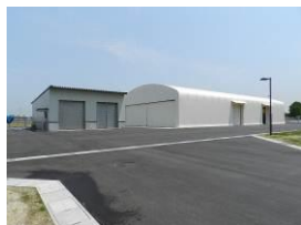
(車庫棟、倉庫棟)
